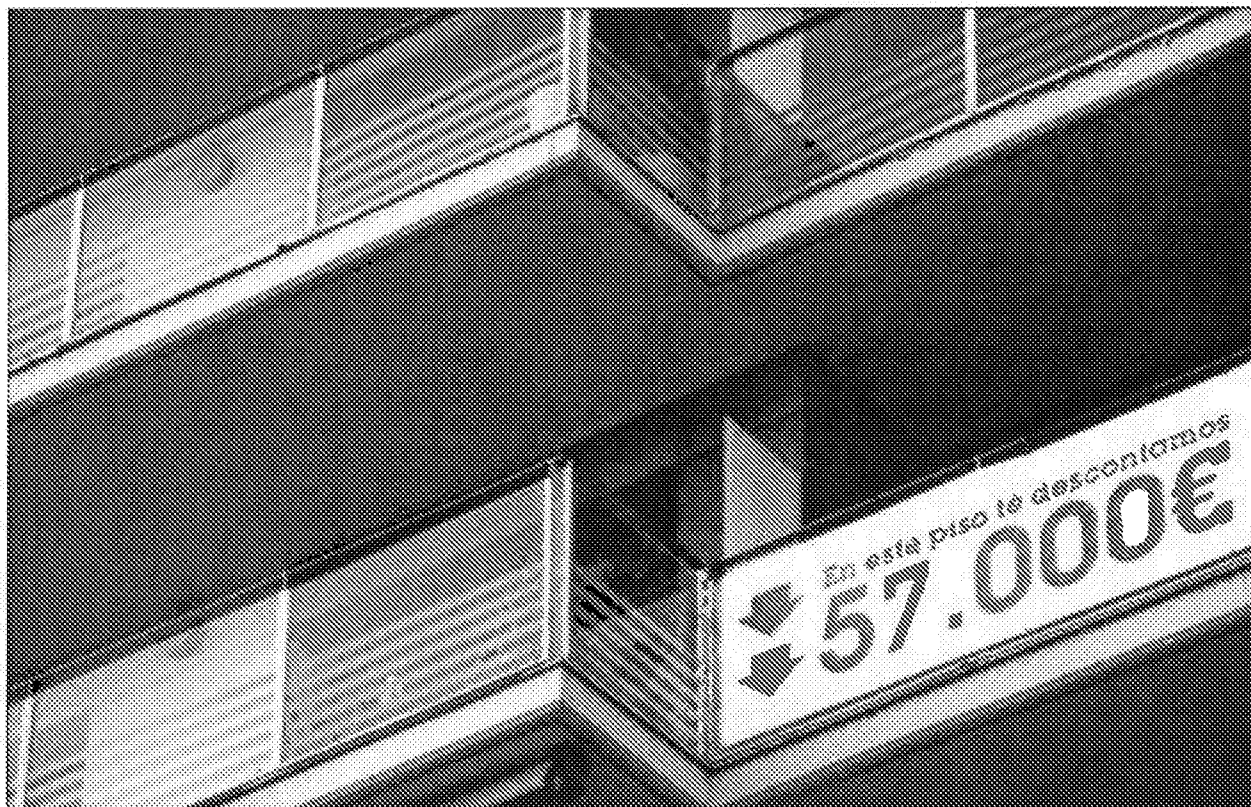
Viviendas de Habitat rebajadas, en el Poblenou barcelonés. / TEJEDERAS
